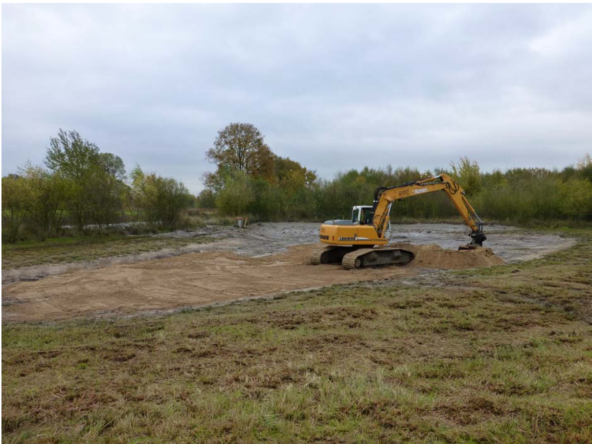
Foto 1: Een poel in het dal van het Merkske waar achtereenvolgens water is weggepompt, zonnebaars is gevangen en zand is aangevoerd om de droogval frequentie te vergroten.
