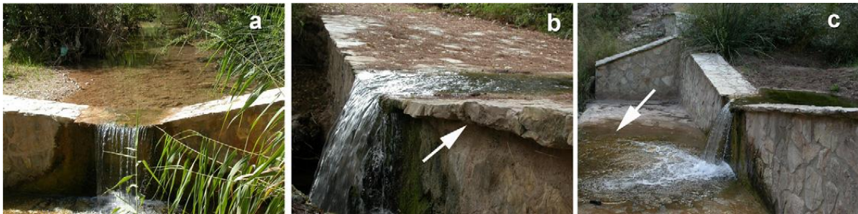
Figuur 6.4: Ontwerp van dammen om de stroomopwaartse verspreiding van invasieve rivierkreeften te beperken, met a) een V-vormige bovenkant, b) afgeschermd rand en c) een platte stenen bodem stroomafwaarts van de dam (uit Dana et al. , 2011).
